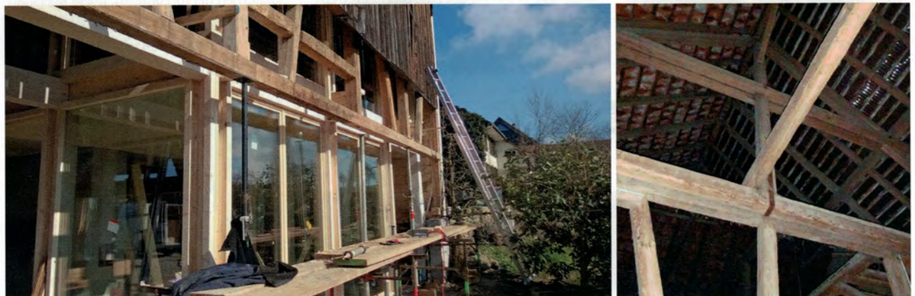
Die alten Balken wurden aufgefrischt und ergänzt, dahinter steht schon die neue Tragkonstruktion.
