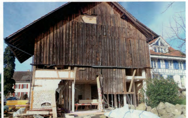
Während im Innern schon die neue Tragstruktur steht, sind noch Teile der alten Fassade zu sehen.
