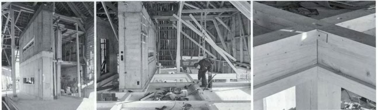
Zuerst wurden die Betonelemente gegossen wie etwa die Bodenplatte oder der (noch zweistöckige) Küchen Kern (links). Danach folgte der Einbau der neuen Tragkonstruktion (Mitte). Die neuen Träger laufen zum Teil durch die Knotenpunkte, sind T-förmig ausgebildet und erlauben so die Aufnahme der hölzernen Bodenplatten (rechts).
