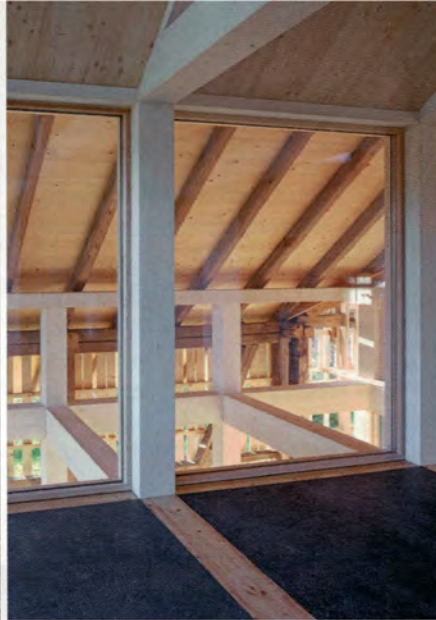
Die Neigung des bestehenden Scheunendachs wurde in der Dachschräge der obersten Wohnung aufgenommen.
