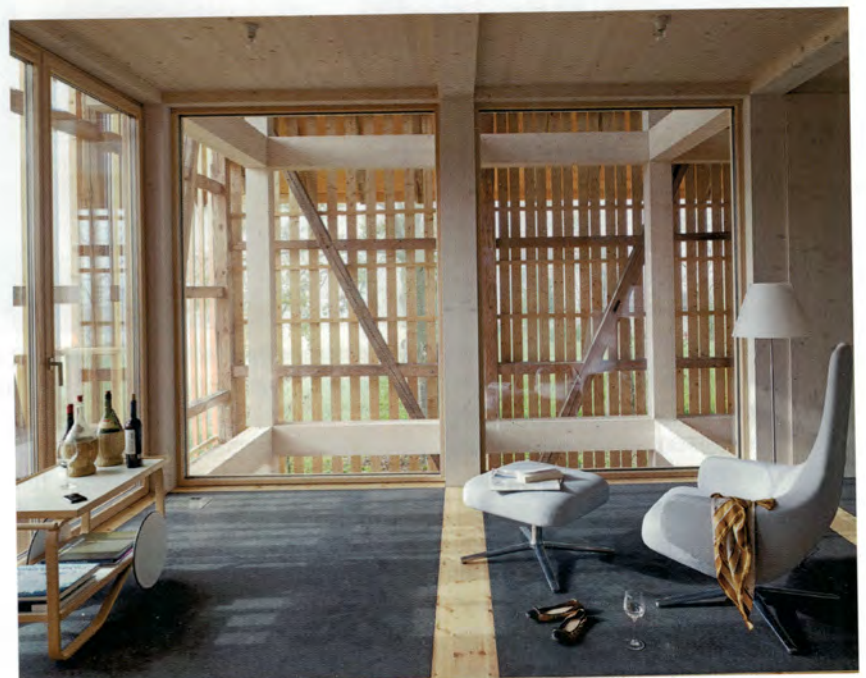
Die neuen Holzfassaden wurden mit unterschiedlichen Öffnungsmustern ausgestattet und ermöglichen so eine differenzierte Beleuchtung der Innenräume.
